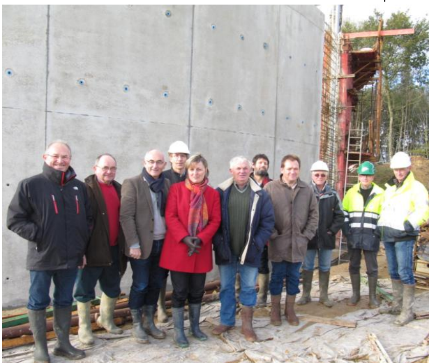
Le conseil syndical visite le chantier le 22 novembre 2013 accompagné des représentants de la SAUR, du SDAEP et de l'Entreprise ROUSSEL
