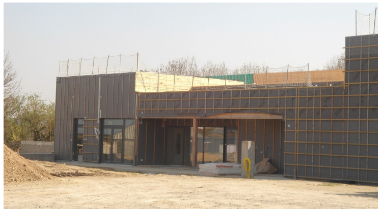
Les travaux de construction de la nouvelle école maternelle Site de la Gare - Future entrée du bâtiment
