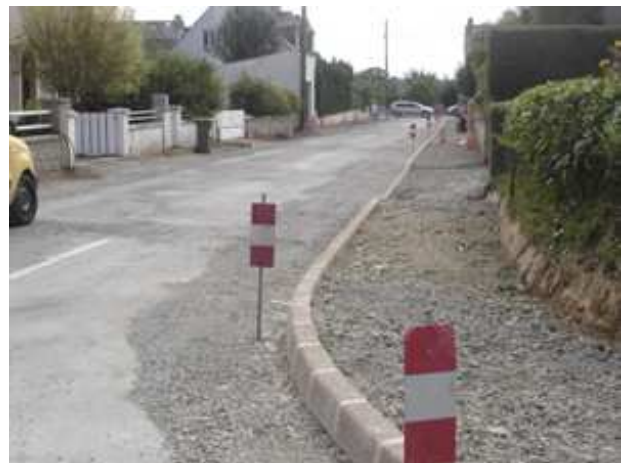
Les travaux se poursuivent rues St Julien , St Maur et La Motte Richard
